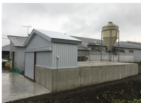
半地上型ユニット浄化槽
